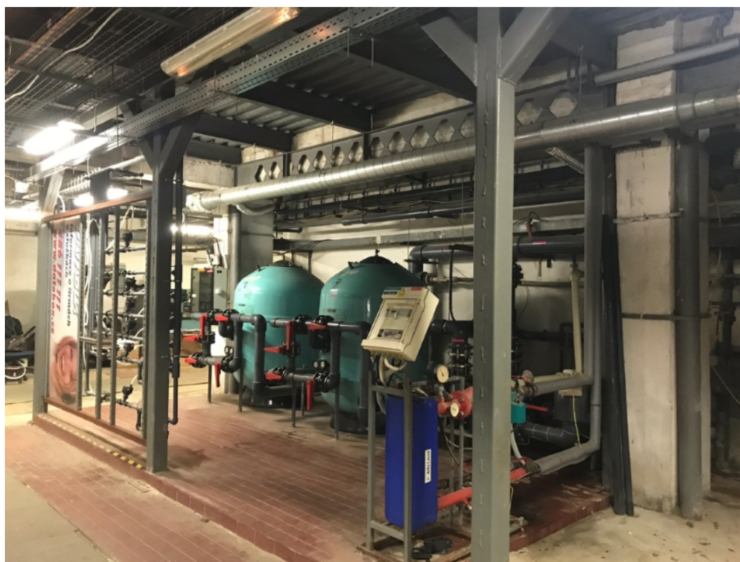
TECHNOLOGICKÉ PODLAŽÍ S02.02 - ocelová konstrukce u technologie dětského bazénu
